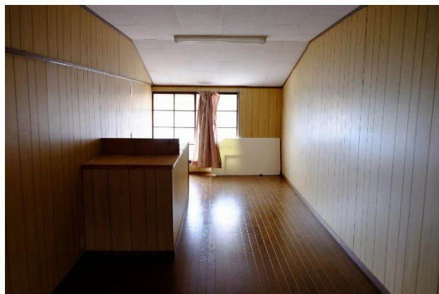
2階店舗西側（ゲストハウストイレ等予定）
